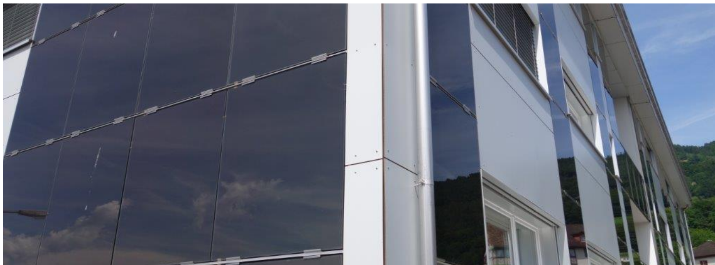
Schweizer Solarpreis 2015 | Plusenergie Mehrfamilienhaus mit fassadenintegrierten Photovoltaikmodulen
