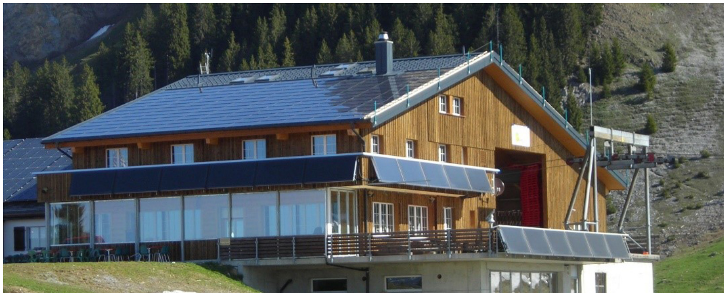
Bergstation mit dachintegrierter Photovoltaik-Anlage
