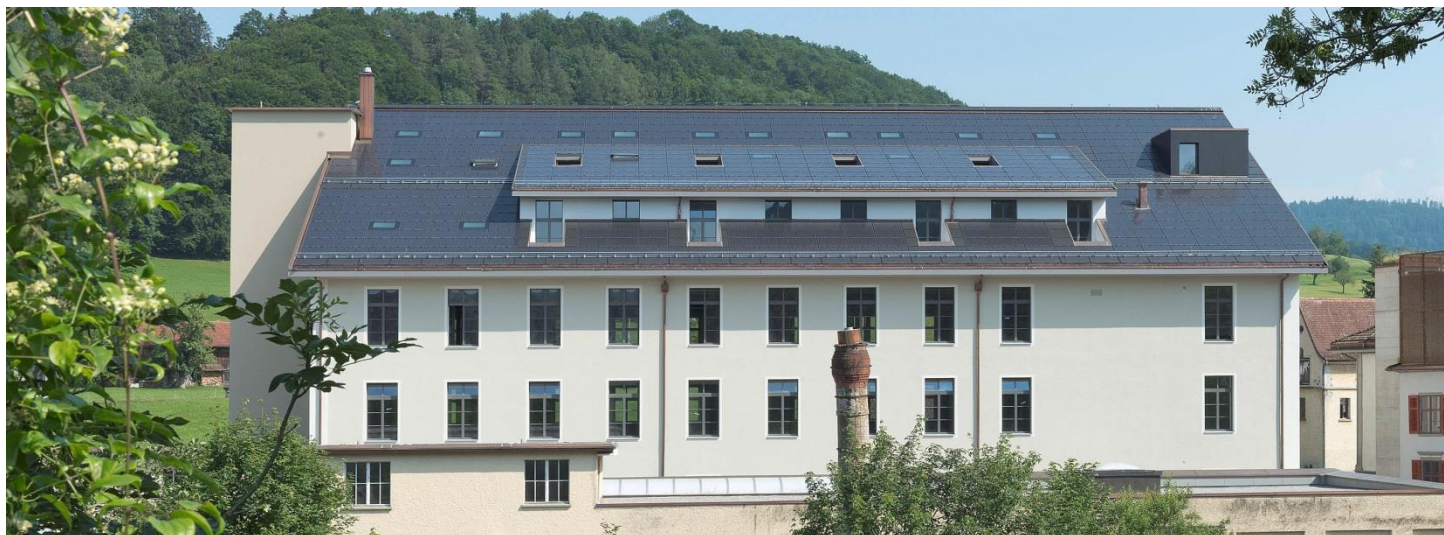
Indach Photovoltaikanlage auf Gewerbebau mit Schneefangsystem
