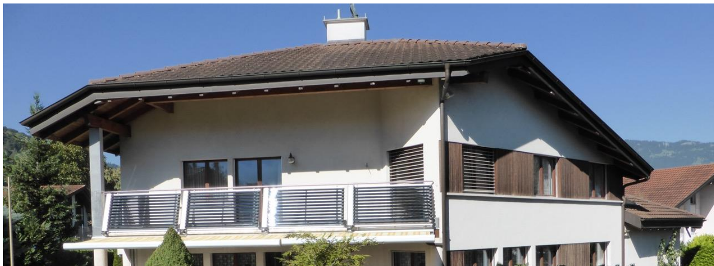
Balkonbrüstung mit Vakuumröhrenkollektoren für Heizung und Warmwasser
