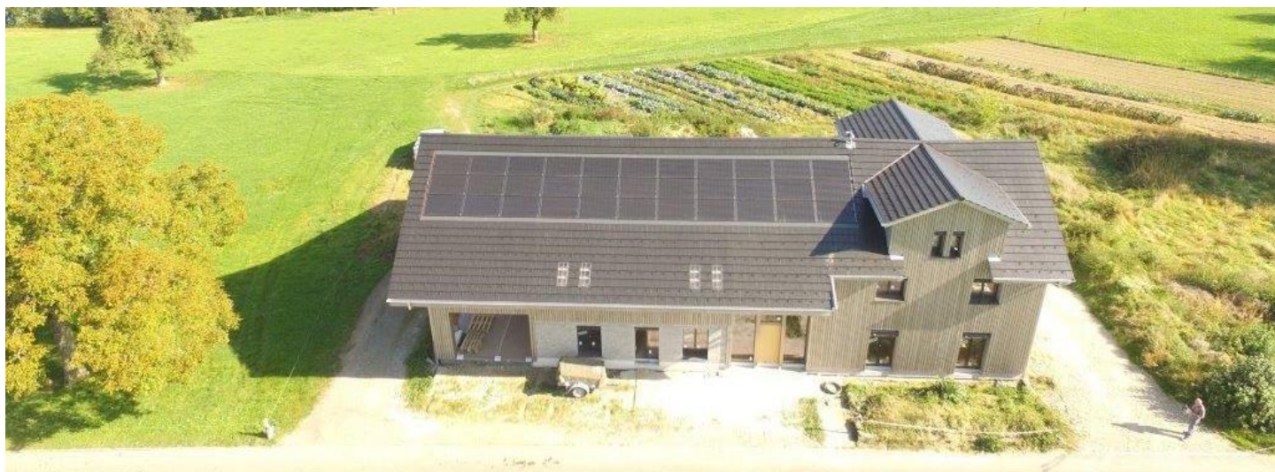
Wärmedämmung des Dachs und neue Dacheindeckung mit Photovoltaikmodulen
