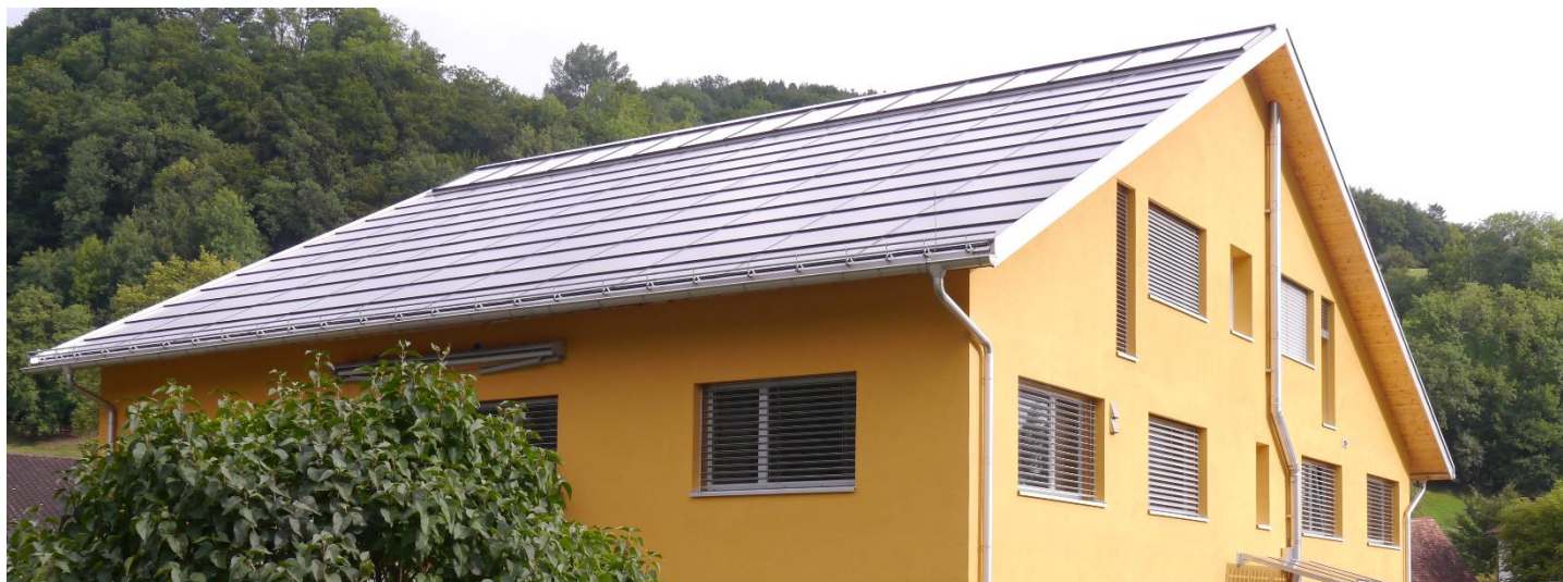
Mehrfamilienhaus mit vollflächiger Solaranlage für die Warmwasser- und Stromproduktion
