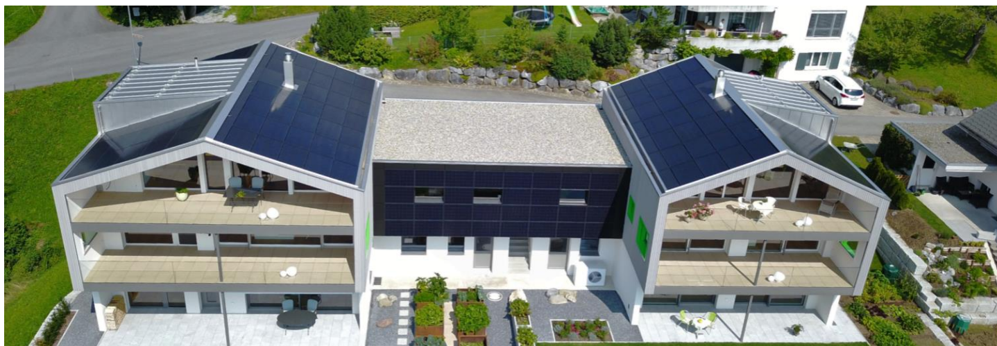
Fassaden- und dachintegrierte Photovoltaik-Module am Neubau
