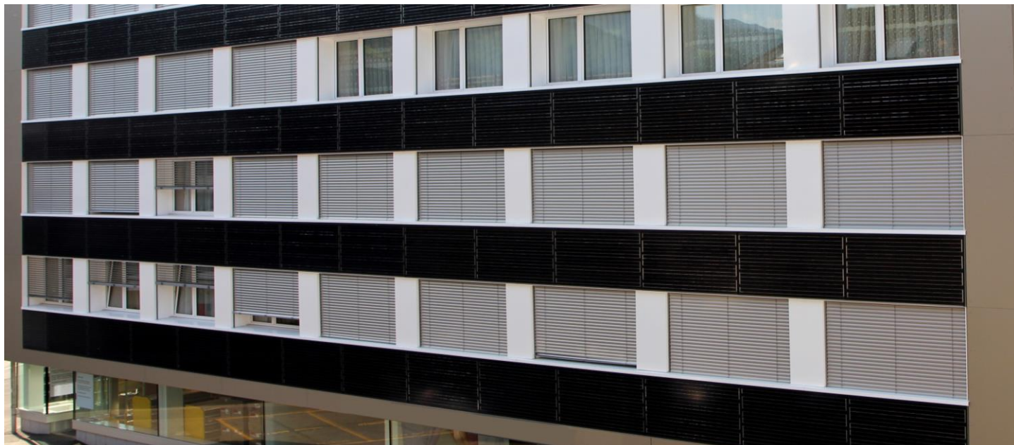
Fassadenmodernisierung mit Photovoltaik-Modulen
