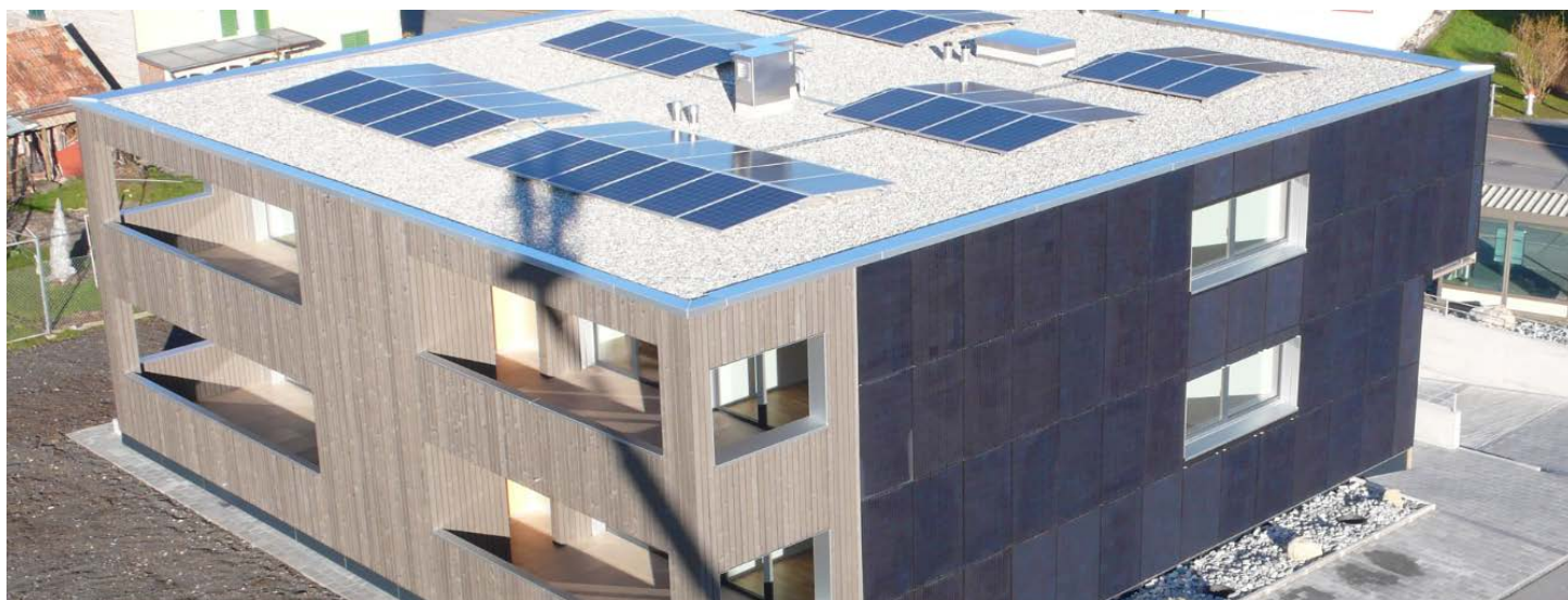
Minergie-A Mehrfamilienhaus mit Aufdachanlage und fassadenintegrierter Photovoltaikanlage
