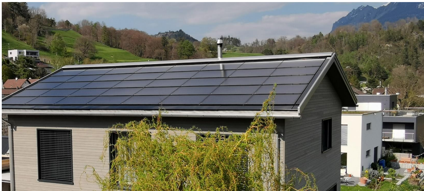
Minergie-P Einfamilienhaus mit integrierter PV-Anlage
