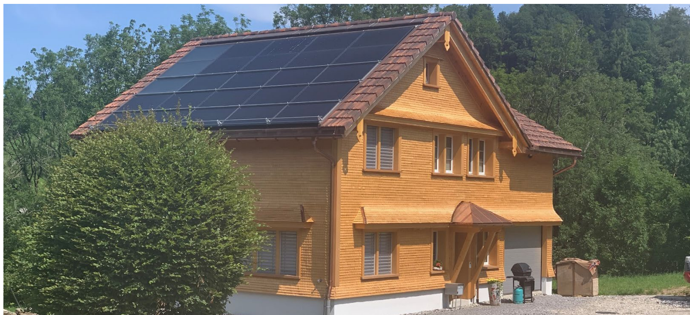
Einfamilienhaus Minergie (SG-2145) mit dachintegrierten Solarthermiekollektoren und Photovoltaikmodulen
